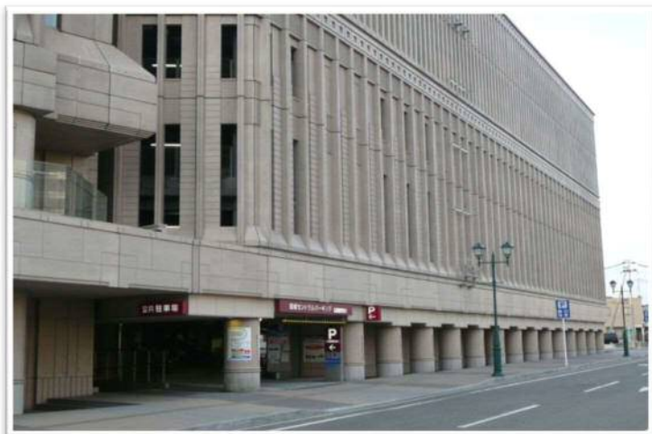
山形駅西口駐車場（外観）
