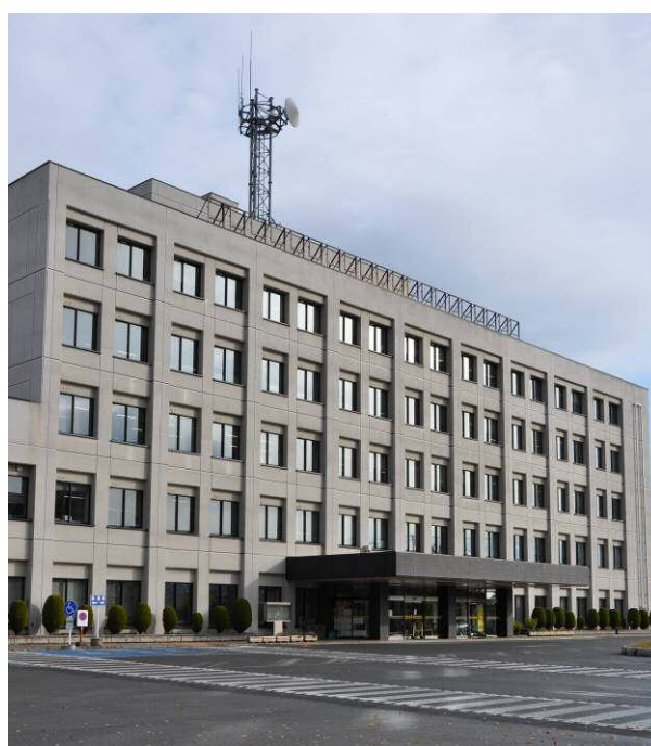
置賜総合支庁本庁舎
