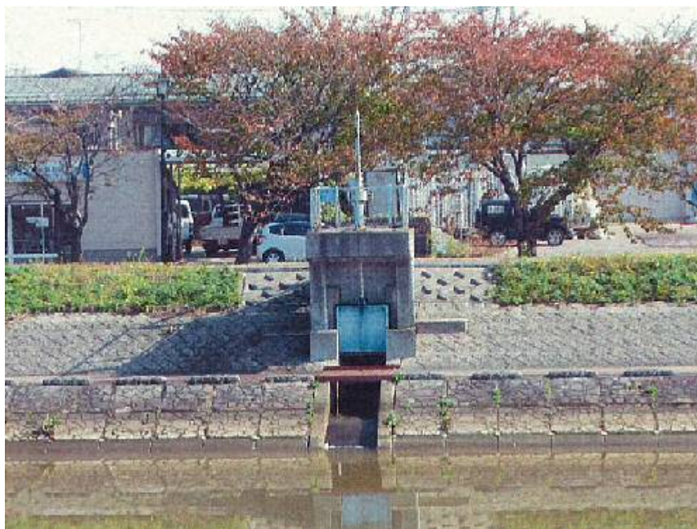
『新井田川「新橋排水樋門（1）」（排水樋門・樋管台帳より）』
