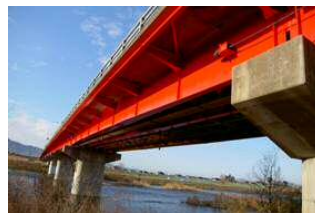
再塗装により長寿命化
