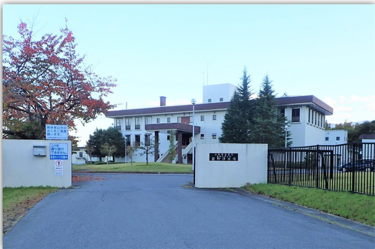
置賜広域水道 笹野浄水場
