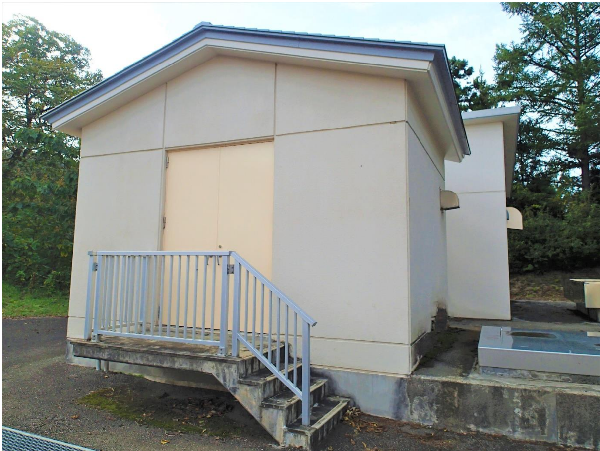
庄内広域水道 鶴岡量水所
