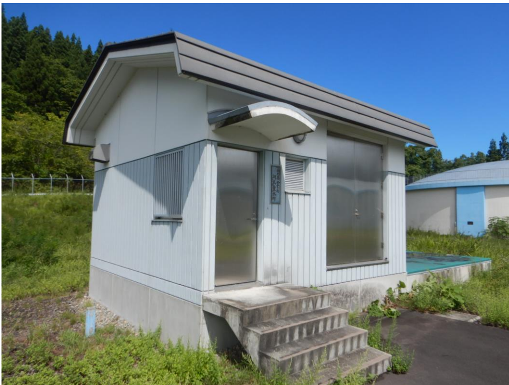
村山広域水道 河北量水所
