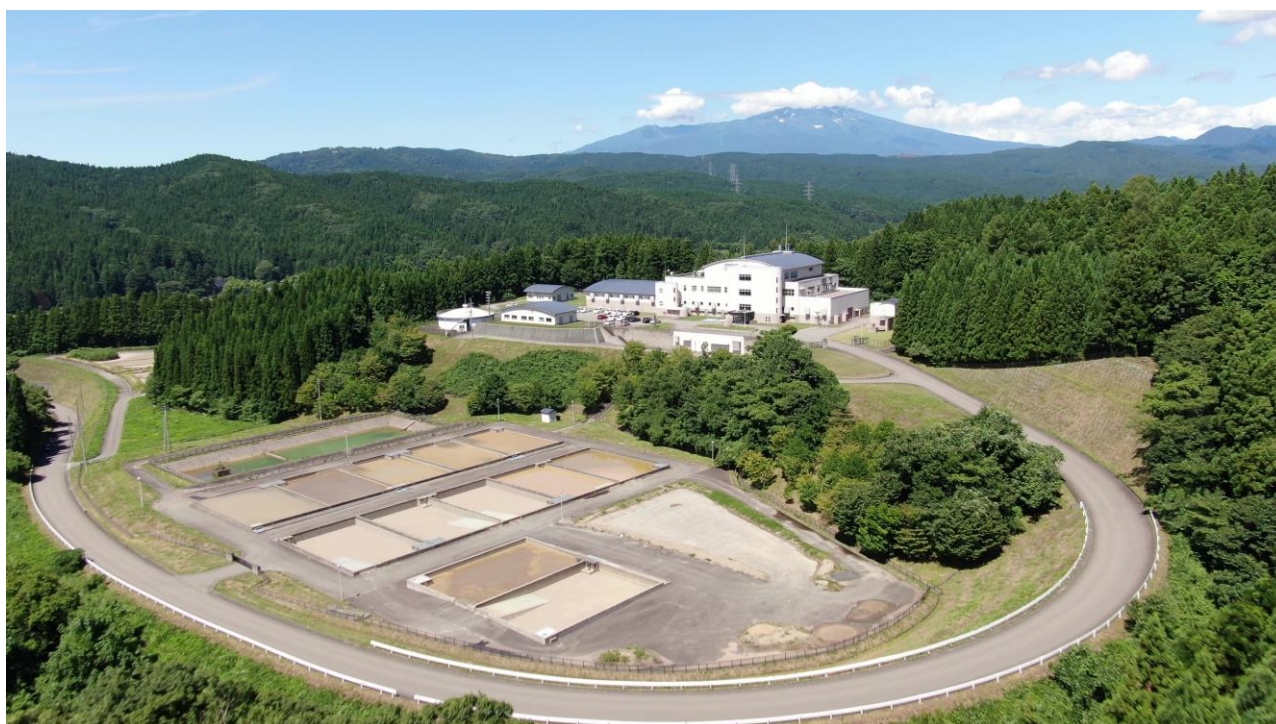
庄内広域水道 平田浄水場
