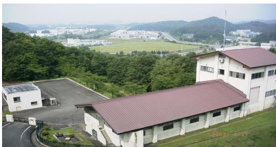
八幡原工業用水道 浄水場（米沢市）
