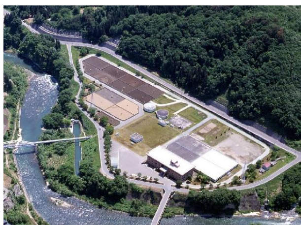
村山広域水道用水供給事業 西川浄水場
