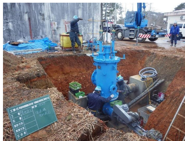
耐震管の布設工事(置賜)
