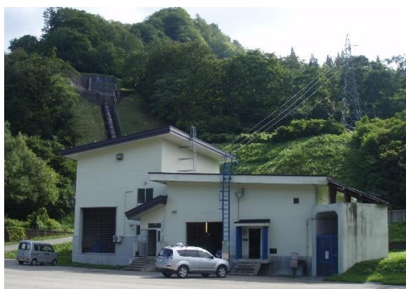
肘折発電所（建屋）
