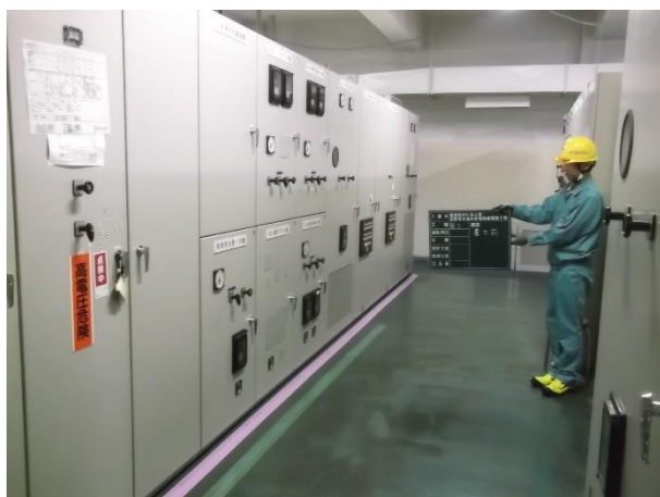
電気設備更新工事の状況(置賜)
