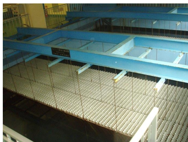
最上広域水道用水供給事業 金山浄水場沈殿池
