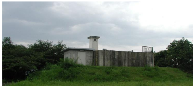
福田工業用水道 配水池（新庄市）
