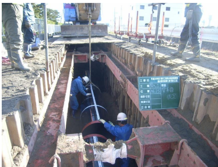
酒田工業用水道 送水管耐震化工事
