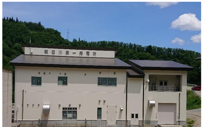
朝日川第一発電所 (R4. 2 リニューアル完成)
