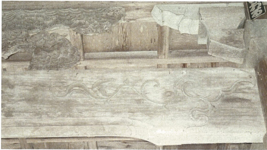
安国寺楼門 1階 水引虹梁
