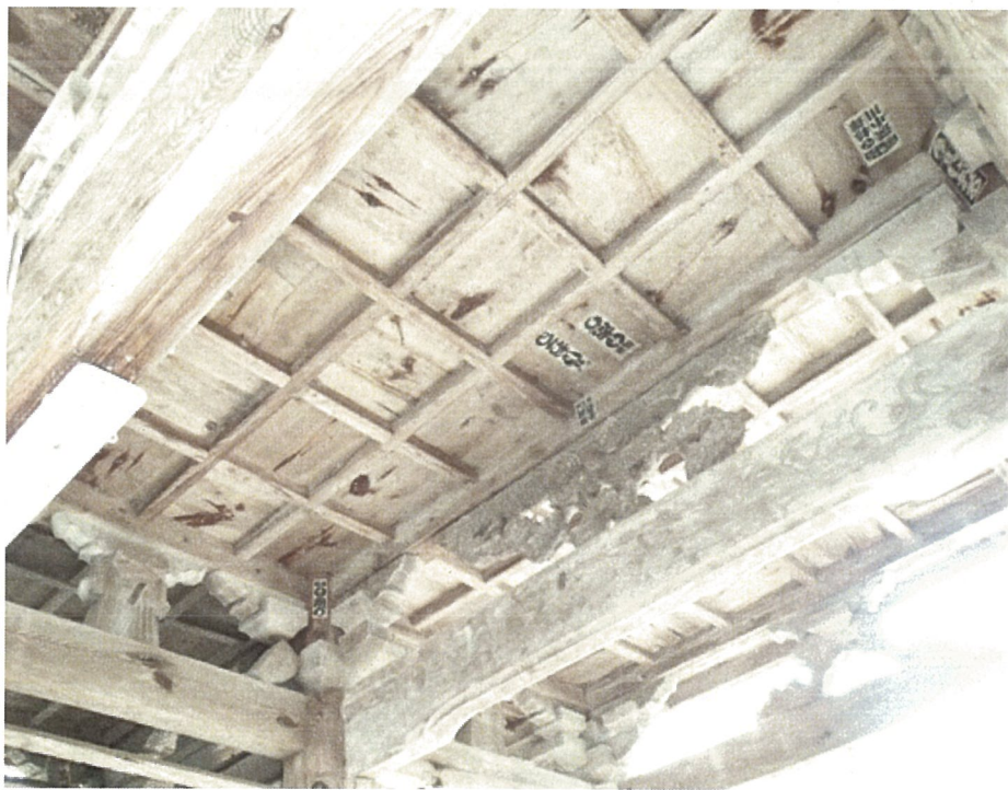
安国寺楼門 1階 天井見上げ
