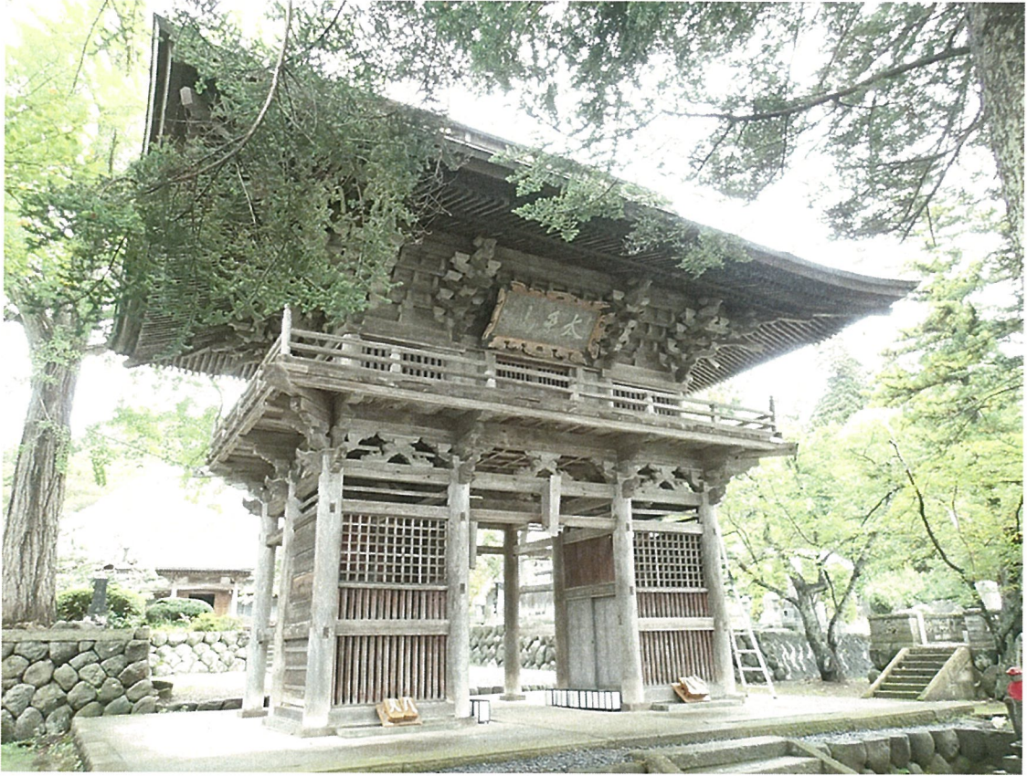
安国寺楼門 正面側
