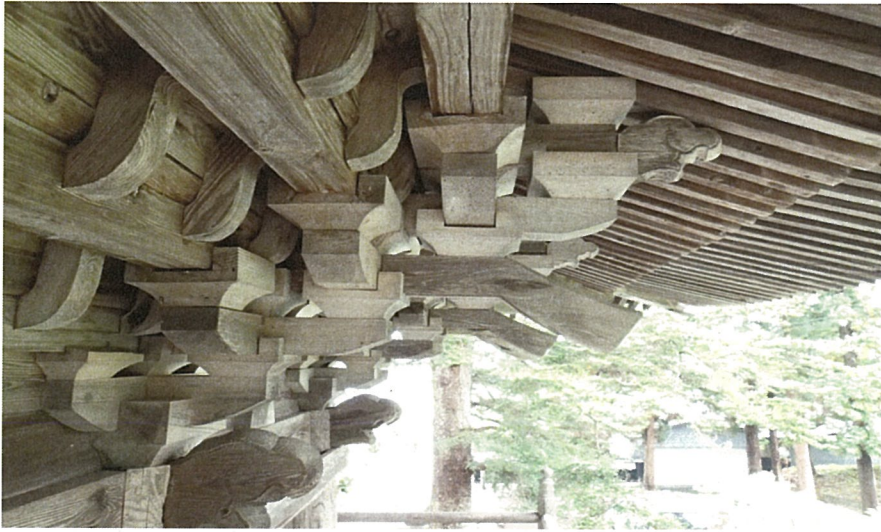
安国寺楼門 2階 組物
