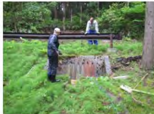
検尺棒で詰まりを取ります
