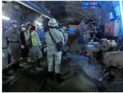
排水トンネルの作業状況
