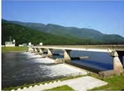
最上川さみだれ大堰
