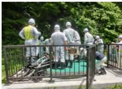
集水井 排水はトンネルに抜く予定
