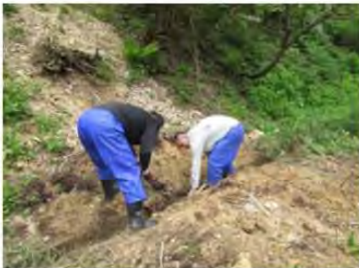
土砂を撤去して水の流れを確保
