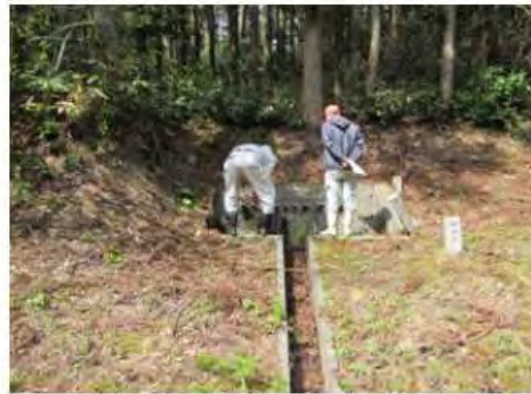
添川地区 水抜きポーリング
