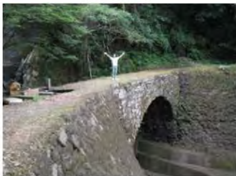
雄亀滝橋(おけだけばし)
