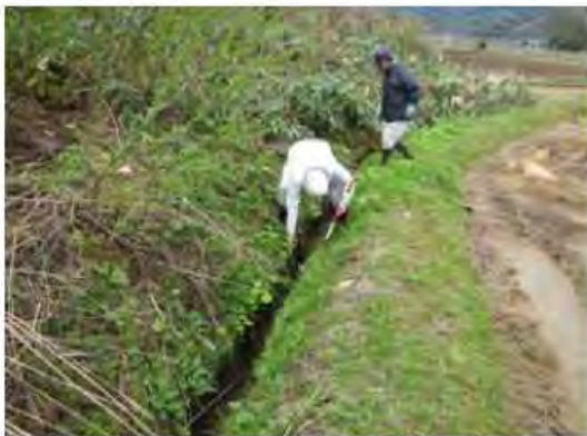
東岩本地区 水抜きポーリング
