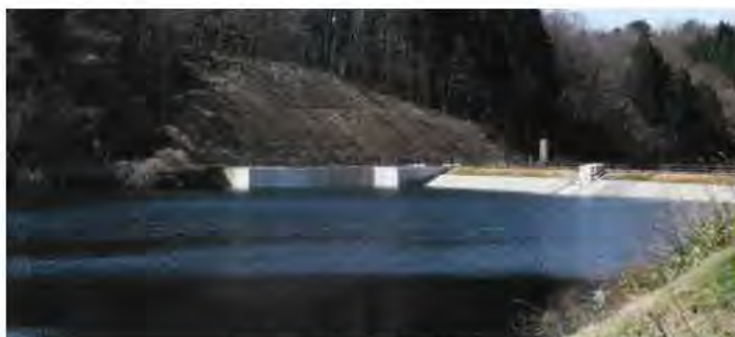
全景(通越ため池堤体)
