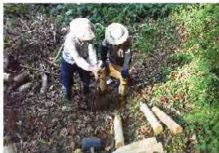
支柱の穴掘り
