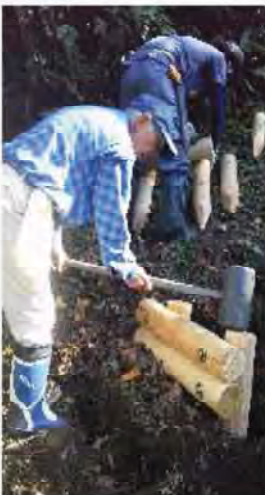
支柱の打ち込み
