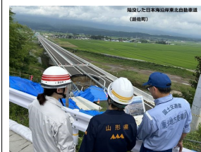
7月27日に陥没した日本海沿岸東北自動車道(遊佐町)を視察する吉村知事(中央)
