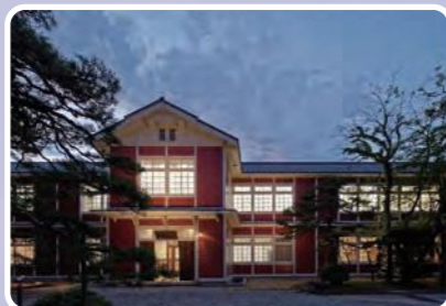
▲旧長井小学校第一校舎
