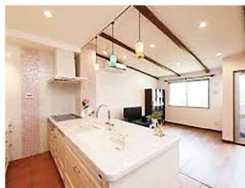
キッチン対面化工事
