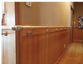
手すり設置工事
