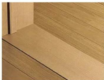
段差解消工事
