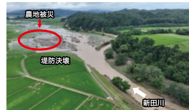
新田川(新庄市本合海)氾濫状況
