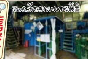
使った水をきれいにする装置。作業に使った水は、特別な装置できれいな水にして川に流します。現場近くの環境も守りながら工事を進めています。
