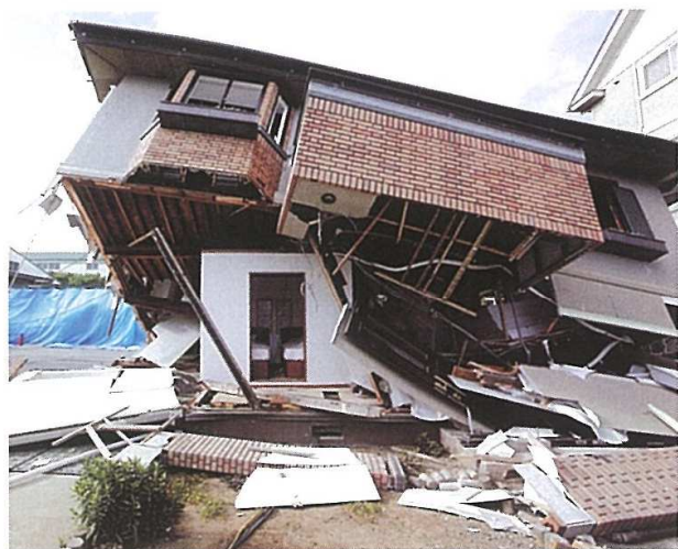
耐震シェルター
