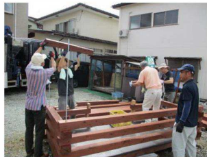
間伐材を利用したごみ集積施設の設置
