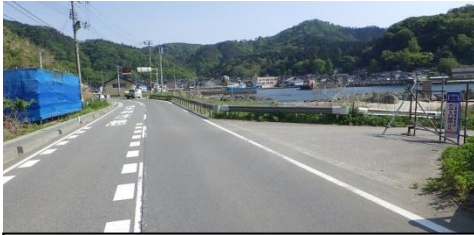
作業ヤード入口
