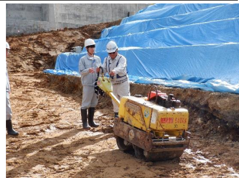
盛土の転圧 (R5実施)
