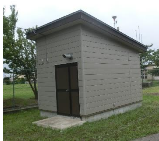
測定局舎（鶴岡錦町局）
