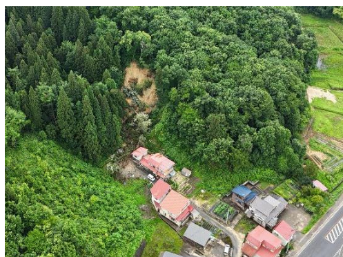
土砂等の撤去 (新庄市大字本合海)
