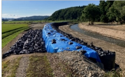
応急堤防工事完了(8/9)
