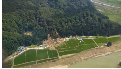
ヘリから撮影・山腹崩壊 (戸沢村大字松坂)
