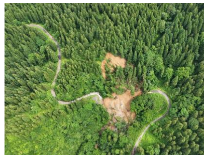
林道路体流出状況 (大蔵村清水)
