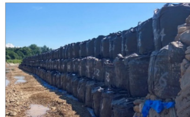
応急堤防工事完了(8/9)
