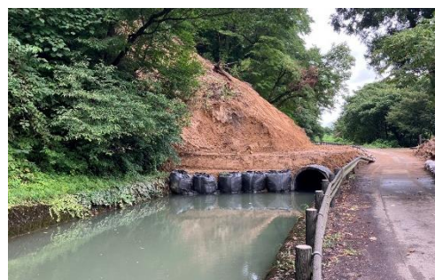
仮設水路の設置
