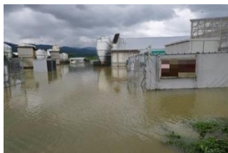
豚舎の浸水状況 (庄内町古関)
