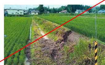
農地 法面崩落(飯豊町 7/26)
