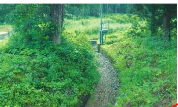
用水路 土砂堆積(小国町 7/26)
