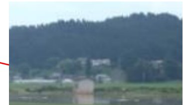
松坂揚水機場 浸水(戸沢村 7/26)
