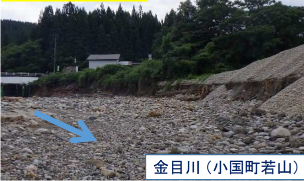
河岸崩壊(50m)及び除雪基地の浸水
