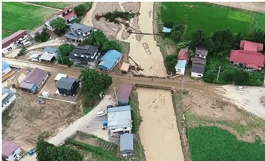
飯豊町萩生地区における浸水被害
