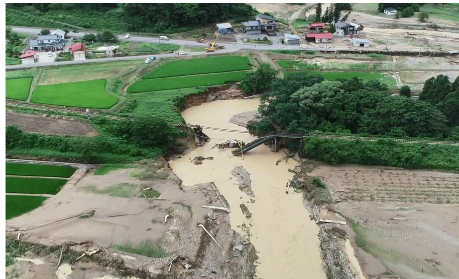
飯豊町小白川地区における浸水被害
