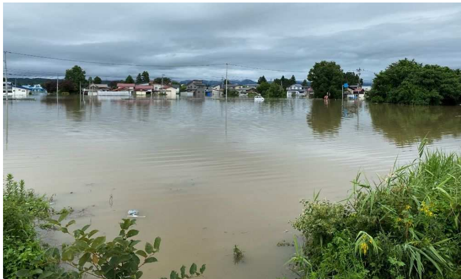
川西町黒川地区における内水被害
