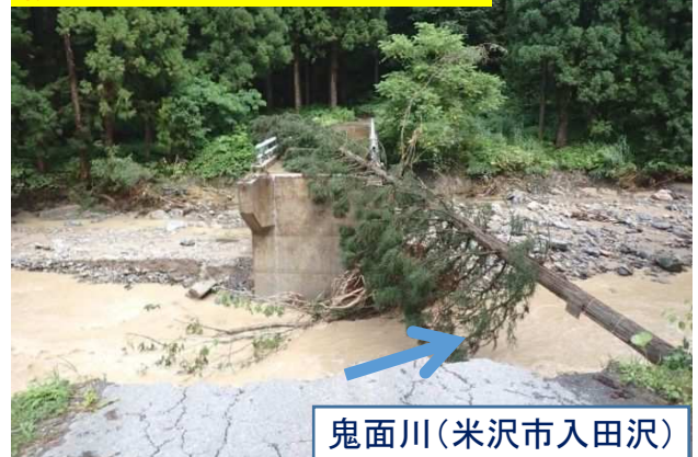
護岸損壊(120m)、市道橋流失
