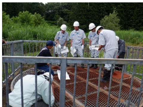
集水井の現況確認(R5実施)
