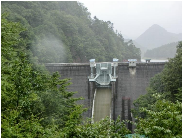
高坂ダム洪水調節状況
