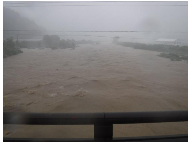
下流河川出水状況
