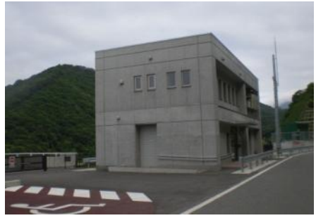
▲ダム管理所外観
