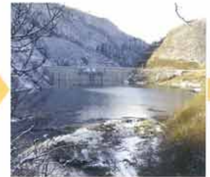
平成22年12月 堤体完成・試験湛水中
