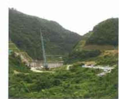
平成21年7月 コンクリート打設の最盛期
