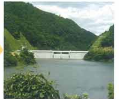
平成23年6月 工事最終期
