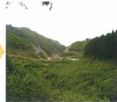
平成19年5月 堤体掘削工事の最盛期
