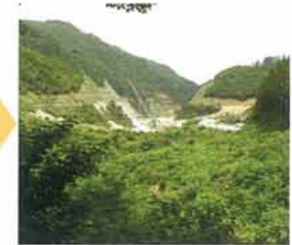
平成20年6月 堤体掘削完了・打設開始直前
