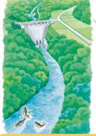
川底と同じ高さ、常用洪水吐き(じょうようこうずいばき)と呼ばれる高さ1.6m(出口では5.6m)、幅1.7mの水路が2本並んでおり、通常時は、流水型ダムがないときと同様に川が流れます。洪水時以外は、水がたまることはありません。
