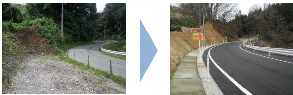
▲地域の実情に応じた道路改良の事例 (主)山形永野線(山形市土坂)の部分的な拡幅
