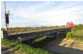
▲(主)庄内空港立川線(三川町) 両田川橋架替(調査)
