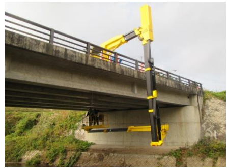
定期点検の状況
