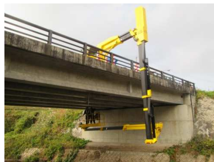
定期点検の状況
