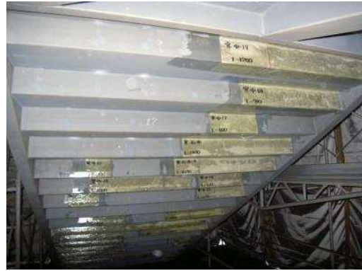
●腐食により欠損した階段部をFRPシート貼付により補修した事例
