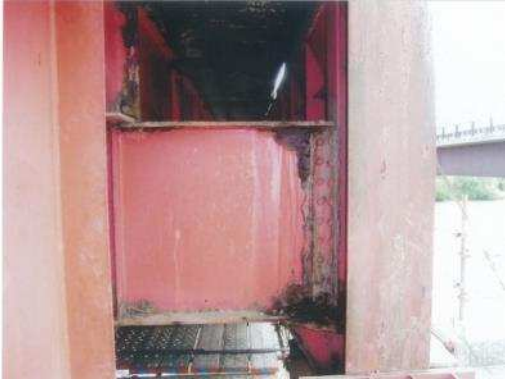
●腐食により欠損した階段部をFRPシート貼付により補修した事例
