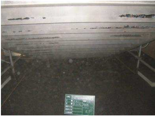
●腐食により欠損した階段部をFRPシート貼付により補修した事例
