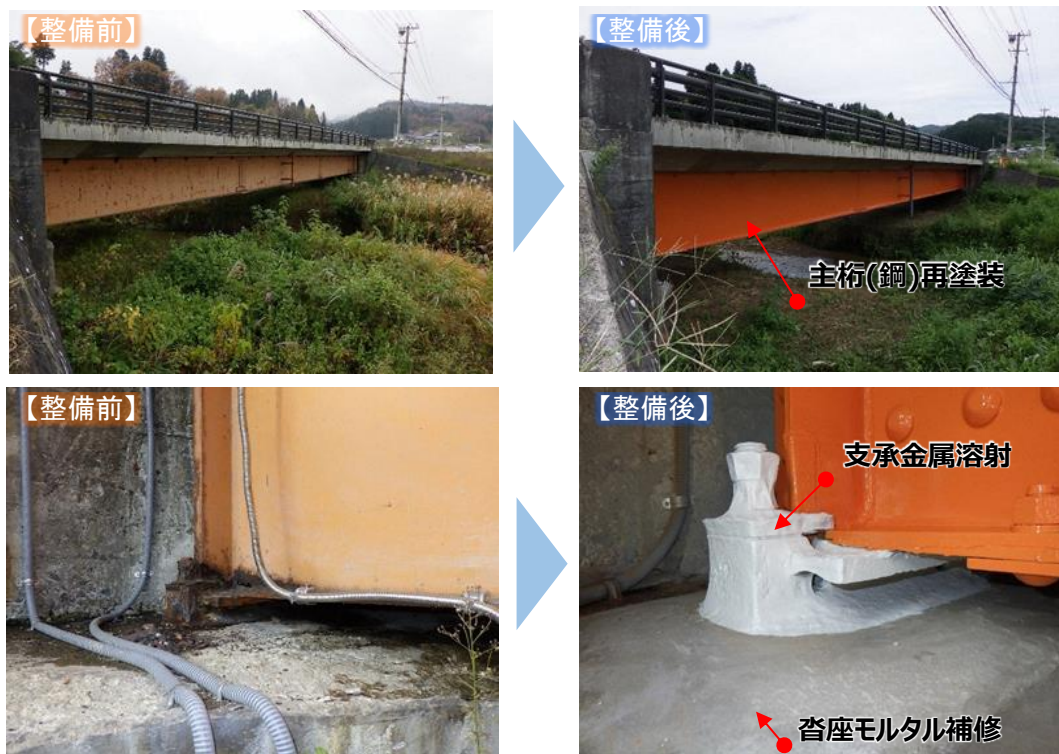
図 3-11 橋梁長寿命化対策例(上:主桁(鋼)の再塗装、下:支承金属溶射、沓座モルタル補修) (主)新庄鮭川戸沢線(戸沢村)濁沢橋
