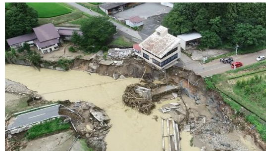
図 3-20 (主)長井飯豊線 大巻橋流失(令和 4 年度)
