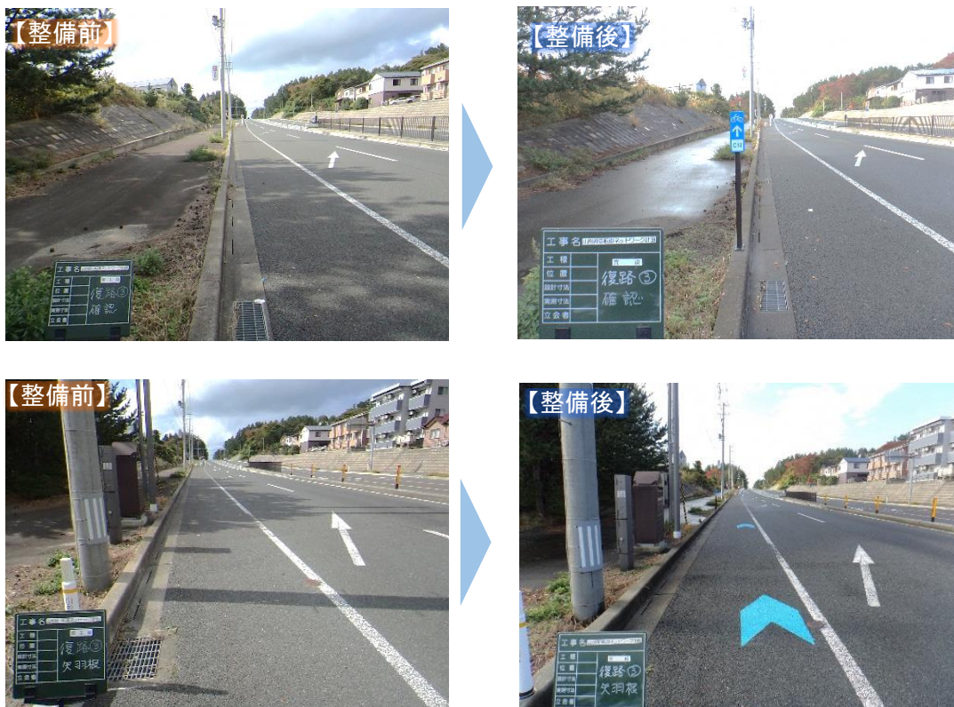
図 3-15 自転車通行帯の整備例(上:自転車案内標識の設置、下:矢羽根マークの表示) (国)112号外 (酒田市浜中～上本町)
