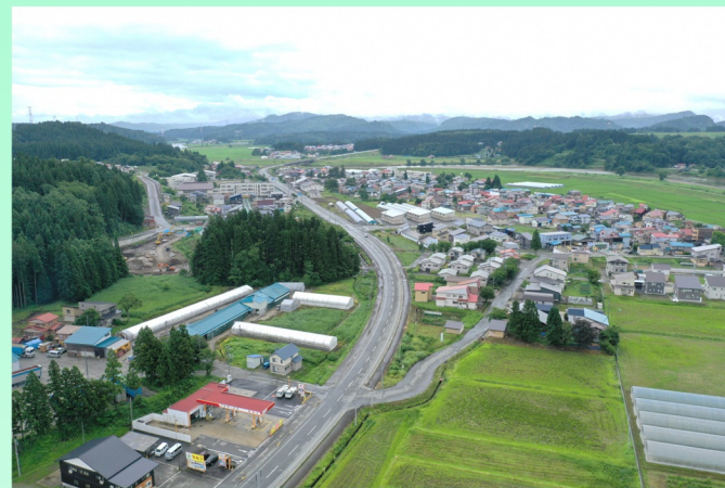
Ⅱ期区間 (合海地区)
