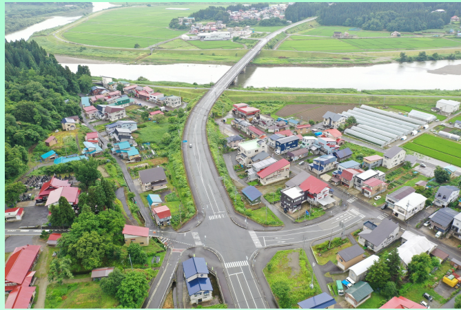
Ⅰ期区間 (大蔵橋及び前後取付部)
