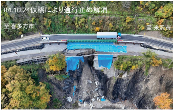
仮復旧状況 R4.10.24仮橋により通行止め解消
