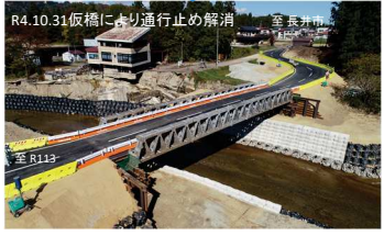
仮復旧状況 R4.10.31仮橋により通行止め解消
