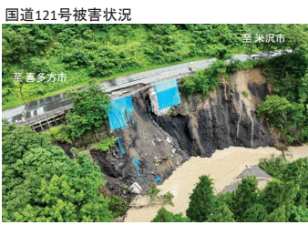
国道121号被害状況
