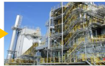
バイオマス発電施設へ
