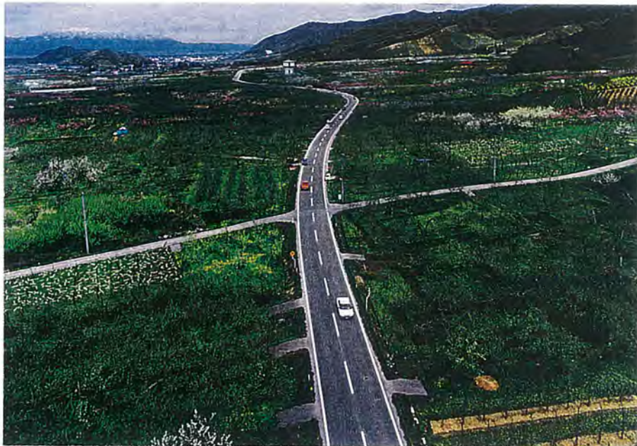
田園地帯に整備された広域農道。既存地形を考慮した道路線形となっている。ガードレール等もなく、沿道の田園や周囲の山並み等が眺められる。(天童市)
