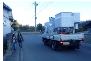
▲(主)大江西川線(大江町顔好)通学路の歩道整備
