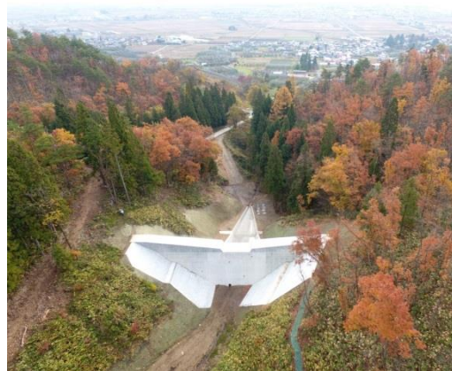
シノ子沢砂防えん堤(河北町)
