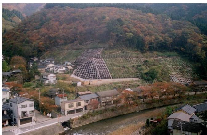
岳の腰急傾斜地崩壊対策事業（鶴岡市：完了直後撮影）
