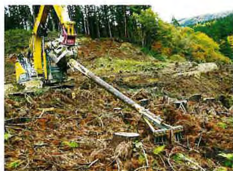
(大型レーキの作業状況)
