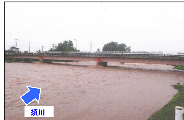
蔵王成沢工区 (令和2年7月撮影) 令和2年7月豪雨時の出水状況 (常盤橋 周辺)
