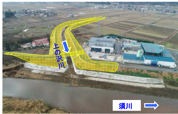
門伝工区 (令和4年11月撮影) 須川・支川(上の沢川) 整備状況
