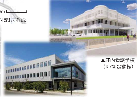
▲鶴岡第2地方合同庁舎 (R4.7完成)
