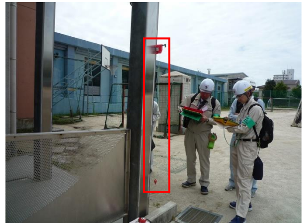
下げ振りによる建物の傾きの確認状況
