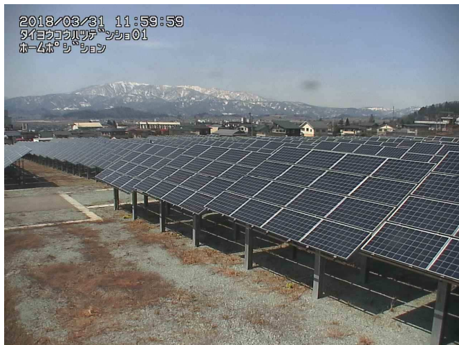
平成30年3月31日 12:00 太陽光発電所の状況
