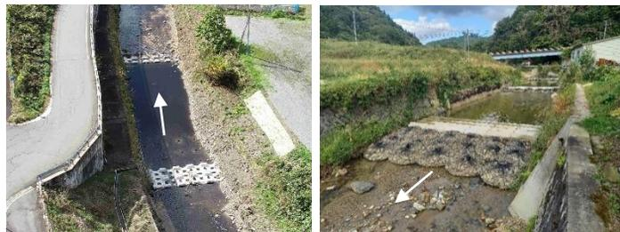
土砂流出による再堆積を防ぐための床止工設置事例 吉野川(南陽市)
