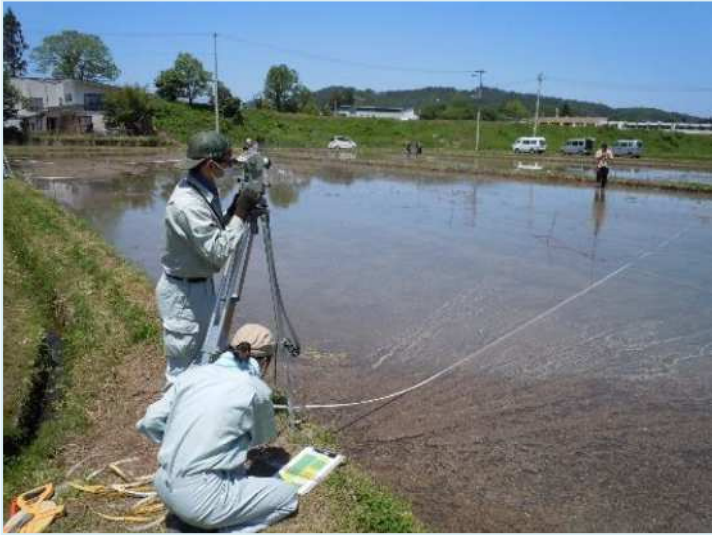
絵の枠取りのための測量の様子
