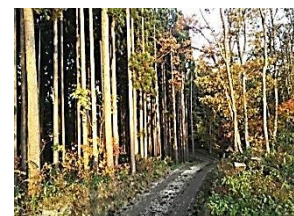
林業専用道の整備
