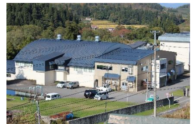
米沢市館山浄水場
