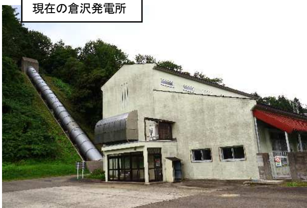
現在の倉沢発電所
