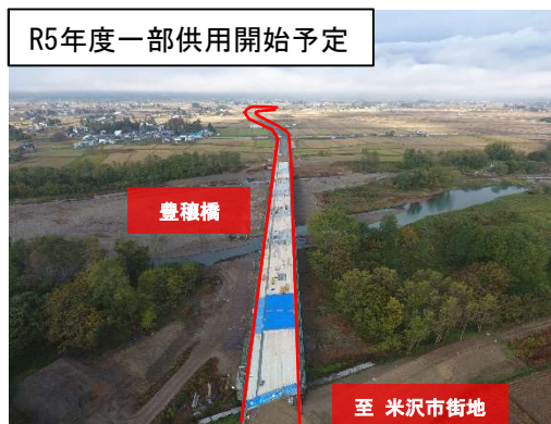
国道287号 (米沢長井道路)
