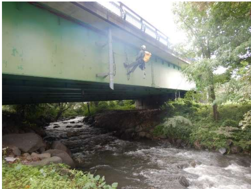
ロープアクセスによる近接目視
