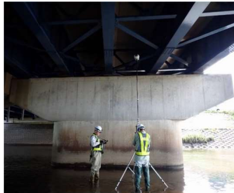
点検ロボットカメラの活用による効率的な近接撮影
