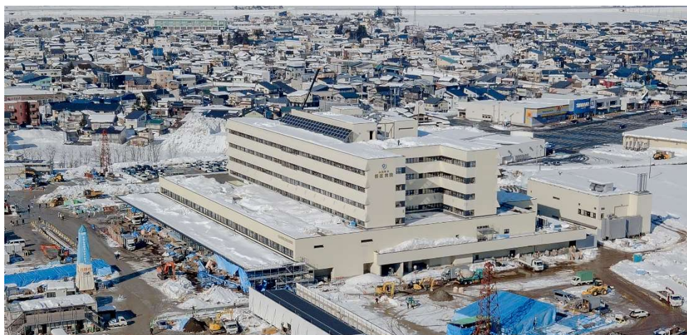
新庄病院 建設状況 (R5. 1. 19撮影)
